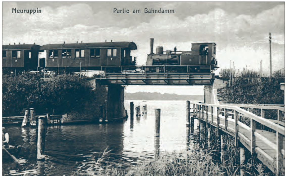
Seedammbrücke für die Eisenbahn. Zu sehen ist auch der hölzerne Treidelpfad für die Kahnschiffahrt. Postkarte vor 1927, Sammlung: U. Bredow
